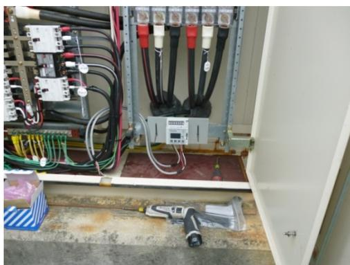
図 1.17 空調機器の電力消費量の測定状況
